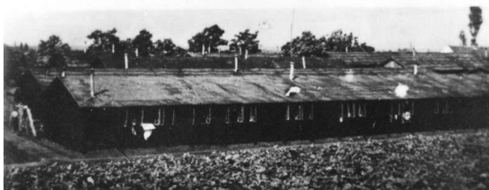
Изглед заводских барака из даљине (ИАСП, ФАОЗ, кутија 6)
